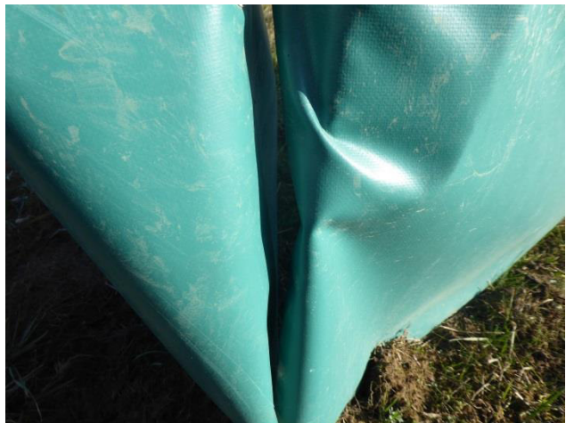
Abbildung 4: Undichte Überlappungen im Zaun.
