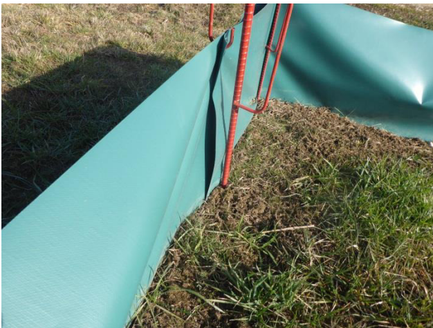
Abbildung 3: Undichte Überlappungen im Zaun.
