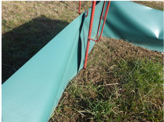
Abbildung 2: Undichte Überlappungen im Zaun.
