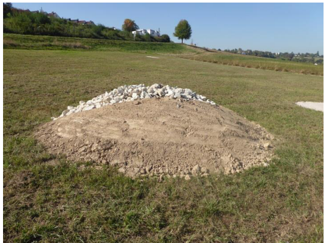
Abbildung 4: Erdanhäufung auf der Nordseite zur Stabilisierung und als Frostschutz.
