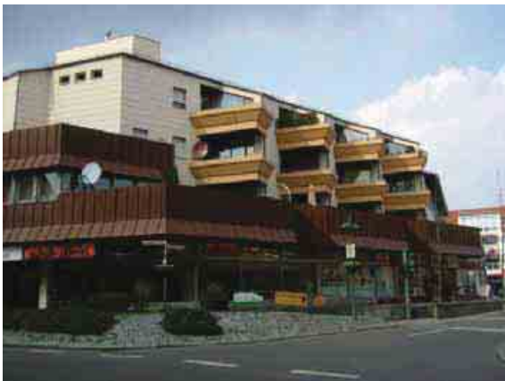
Foto 30: Fehlende Querungsmöglichkeit für Fußgänger durch Niveauunterschied
