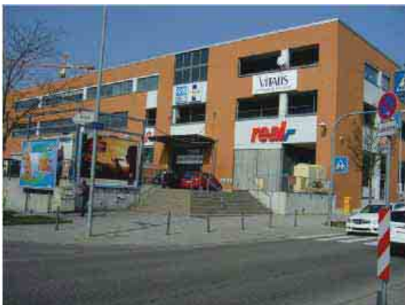
Foto 42: Schmäler, nicht ebenerdiger Eingangsbereich des SB-Warenhauses
