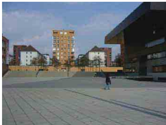
Foto 41: Platzbereich vor Stadthaus mit spärlicher Möblierung
