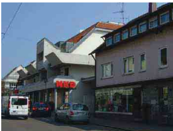
Foto 7: Uneinheitliche Architektur in Heumadener Straße
