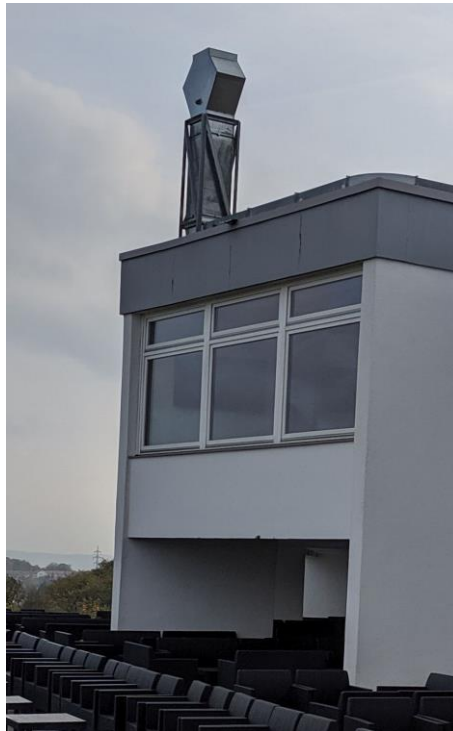
Abb. 5-2: Blick auf den Abluftkamin der Shisha-Bar aus Richtung Breslauer Straße (Aufnahme vom 30.10.2019).
