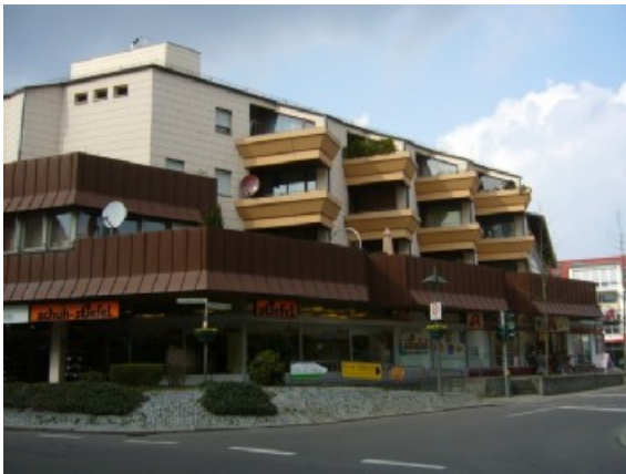
Foto 30: Fehlende Querungsmöglichkeit für Fußgänger durch Niveauunterschied
