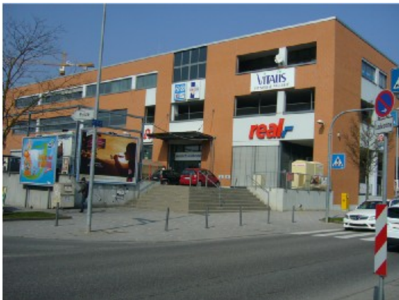
Foto 42: Schmäler, nicht ebenerdiger Eingangsbereich des SB-Warenhauses
