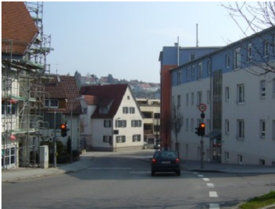
Foto 34: Funktionaler Bruch in Ruiter Straße
