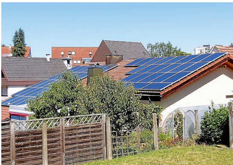
In der Stadt sind noch viele Dachflächen für die Energiegewinnung nutzbar.
