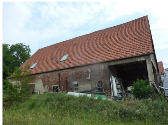
Abbildung 4: Große Scheune im nördlichen Bereich mit Einflugmöglichkeiten für gebäudebrütende Vögel und Fledermäuse.
