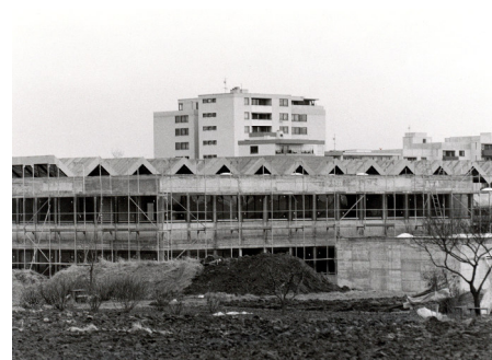
Rohbau der TAE in Nellingen, 1975 Der Bau wurde zeitgemäß in Beton ausgeführt. Die zackenförmige Dachkonstruktion gab dem Gebäude eine markante Architektur.
