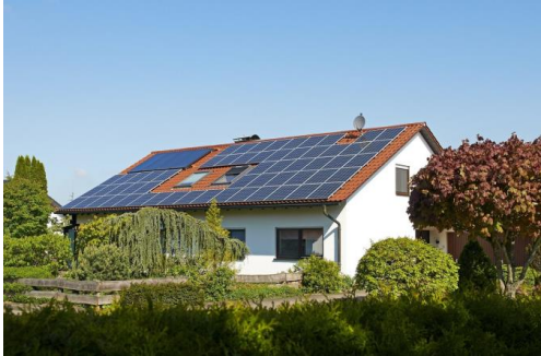
Dach (Süd, West, Ost...)
