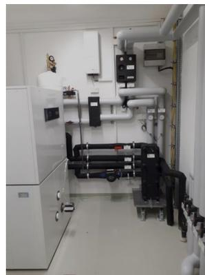
Auch hier erfolgt die Beheizung über eine Fußbodenheizung, mit den Erdsonden kann das Gebäude in den Sommermonaten auch gekühlt werden (mit sehr geringem Stromeinsatz). Innenliegende und Sanitärräume haben eine Abluftanlage.
